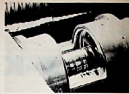
Afb. 5. Verbindingsbus, even voordat deze wordt dichtgelast.
